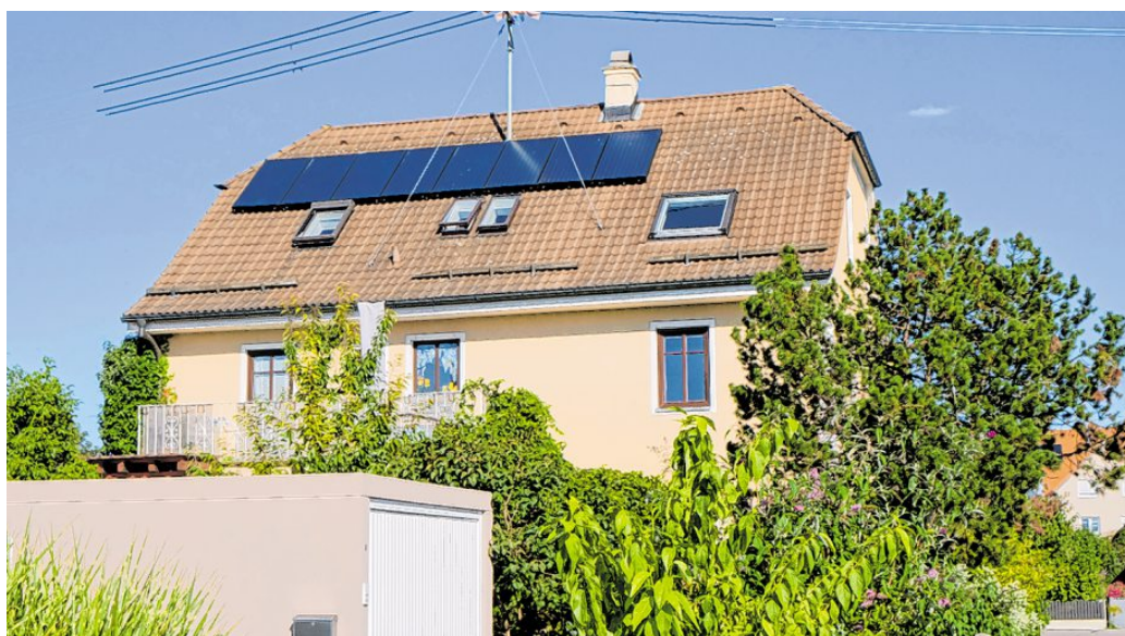
Eine Solaranlage lässt sich bei der Sanierung gut mit in die neue Heizungsanlage integrieren.
