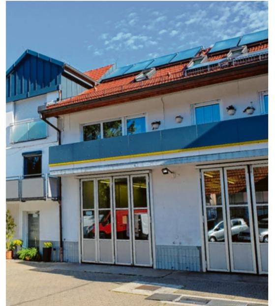
Zusätzlich zur neuen Gasbrennwerttechnik im Keller wurde eine Solaranlage auf dem Dach des Wohnhauses der Familie Menhofer für die Heizungs- und Warmwasserunterstützung installiert. Foto: Markus Makosch
