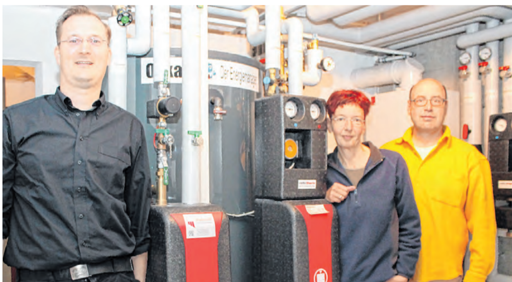
Markus Makosch (links) mit Sonja Landwehr und Martin Borowitz in deren Keller. Die Bobinger Firma führte eine Heizungsanierung bei den Eheleuten durch. Foto: Sonja Grimm
