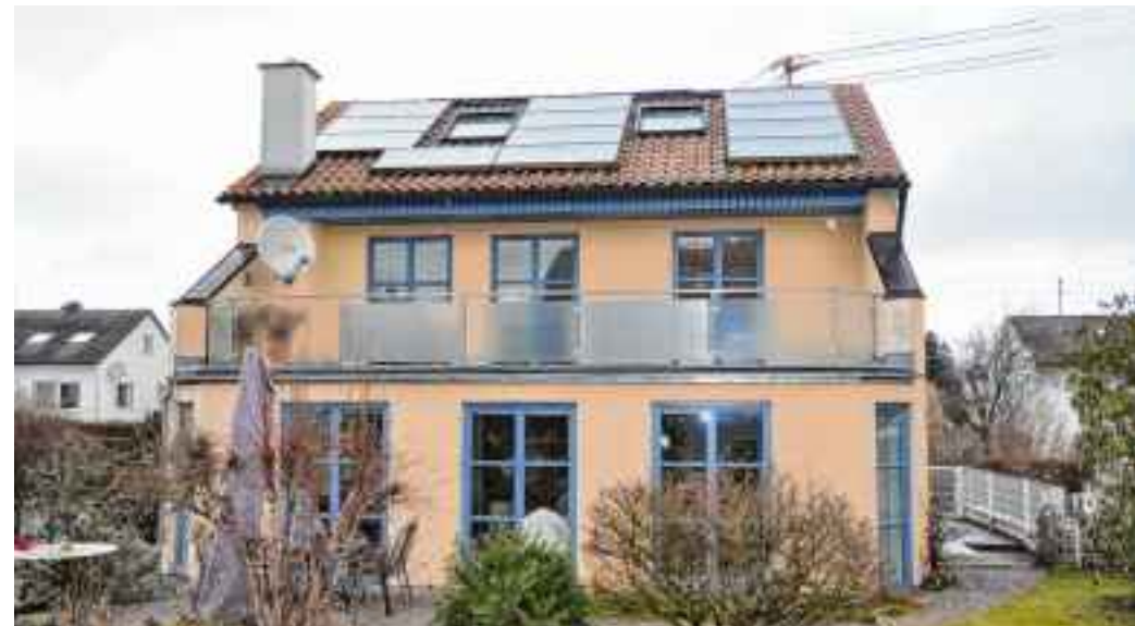
Häufig lässt sich bei der Sanierung eines Objektes auch die bestehende Heizung mit in das neue Konzept integrieren.
