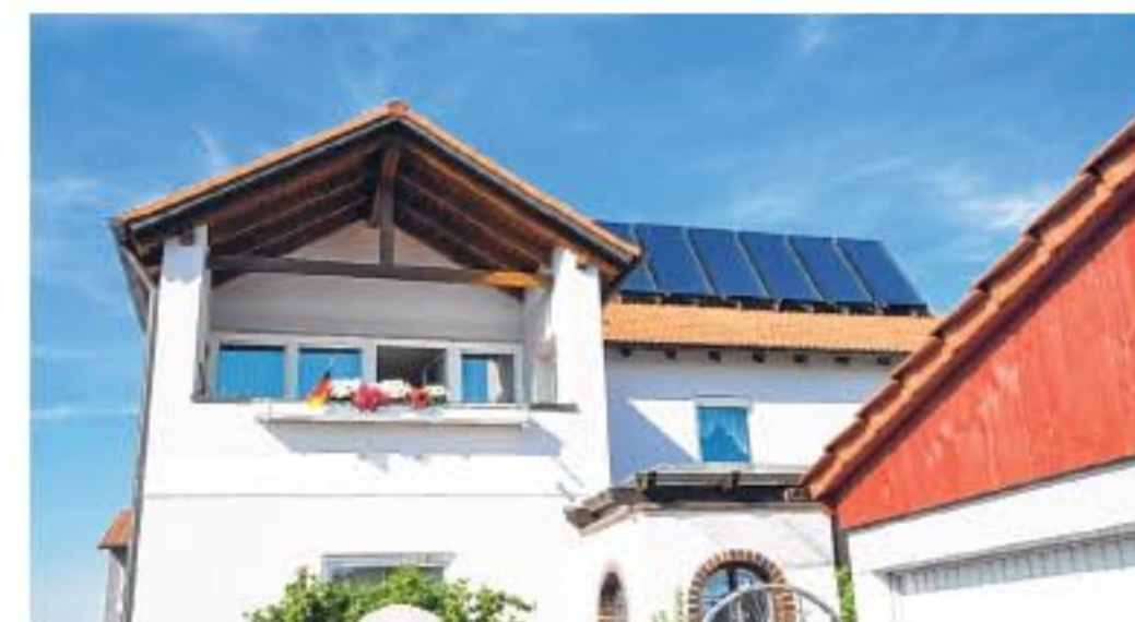
Seit die Firma Makosch eine Solaranlage auf dem Dach von Manuela Hejazi angebracht hat, freut sich die Bobingerin doppelt über sonnige Tage.
