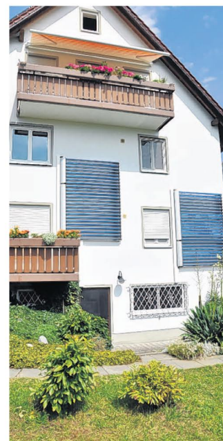
An der südlichen Hauswand wurden die Kollektoren angebracht.
