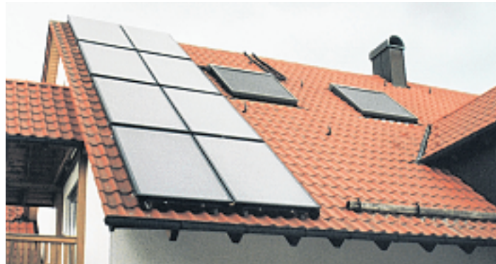
Für jedes Dach gibt es die perfekte Lösung: Die Solaranlage der Familie Zechmann dient der Heizungs- und Warmwasserunterstützung. Foto: oH
