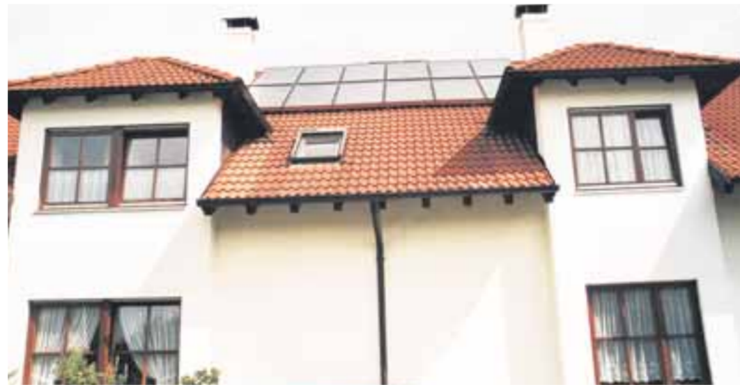
Über zwei Doppelhaushälften erstreckt sich die Solaranlage. Der Deckungsanteil am gesamten Heizwärmebedarf beträgt je nach Witterung zwischen 30 und 40 Prozent. Foto: oH
